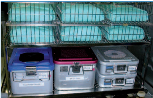
Abb. 6: Restfeuchte und mögliche Beschädigungen sind rundum nur beim Korb/Sieb-system beurteilbar
